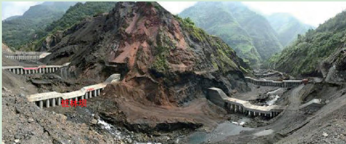
图 3-2-1 都坝河上游物源区建造的桩林坝
